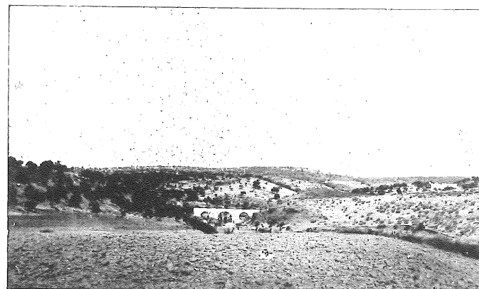
Almodóvar y Posadas.—Carretera a Palma. Puente sobre el Guadiato.
